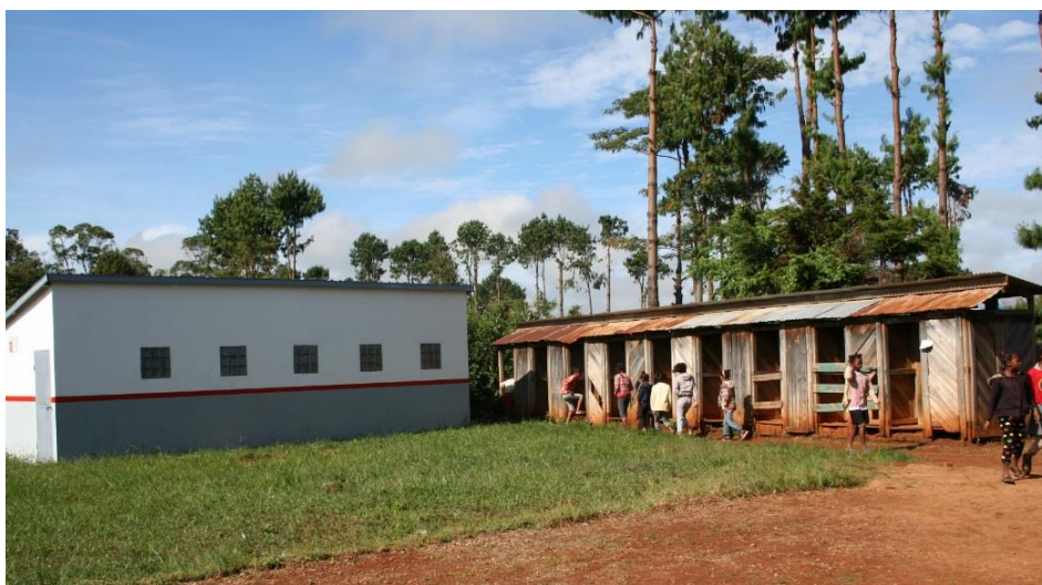
A gauche : Nouvelles toilettes construites à Madagascar dans une école primaire près d'Antsirabé (CODEGAZ et l'entreprise HOLCIM Madagascar)
