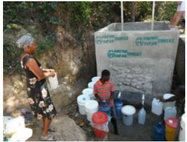
HAITI : rénovation du captage de source à Gressier
