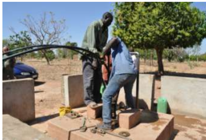
BURKINA FASO : Forage profond d'eau potable ( Guibare)
