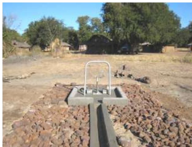
MADAGASCAR : Forage à Mahaboboka : la machine en fonction, le forage et sa plate-forme terminés
